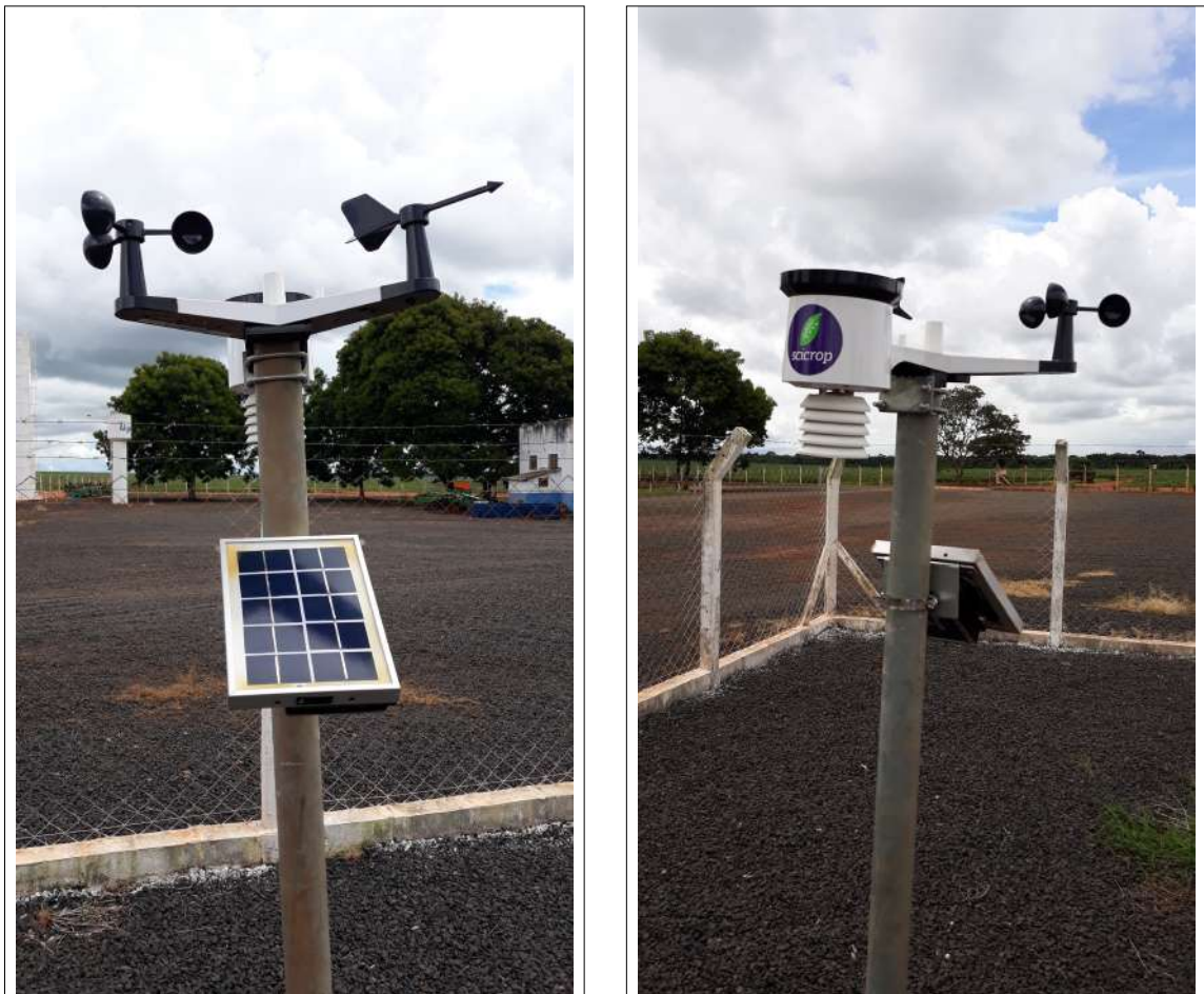
Figura 44 – Detalhes Instalação SciCrop - Vista 1.
